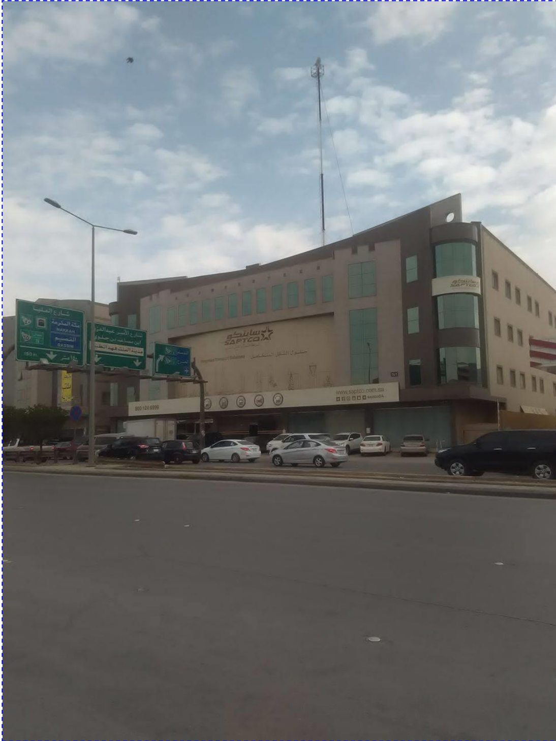
مبنى شركة سابتكو للنقل للنقل الجماعي بشارع الضباب
